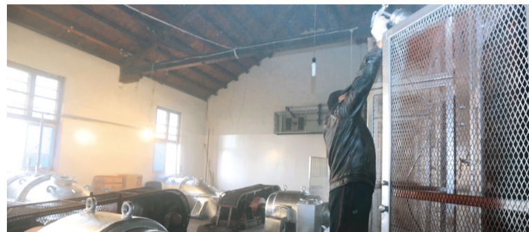
日前, 徐圩投资公司供水中心集中人力对全公司 12 个纳潮扬水机站、网站进行“拉网式”检查, 并根据机械设备老化程度, 列出详细保养清单, 及时抽调骨干力量分片开展机械设备除锈和油漆保养工作, 为今冬明春盐生产用水提供供水保障。(汪洋)
